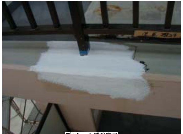
デカシール補強完了
