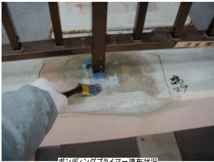
ボンディングプライマー塗布状況
