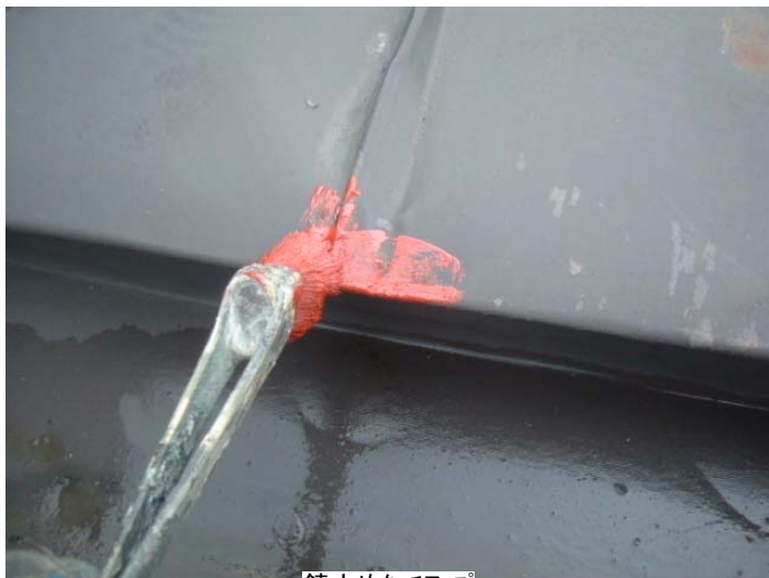
錆止めタッチアップ
