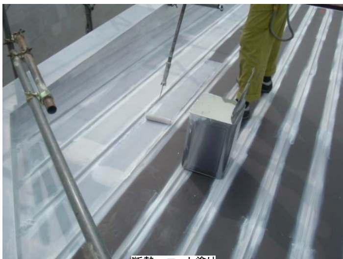
断熱αコート塗り
