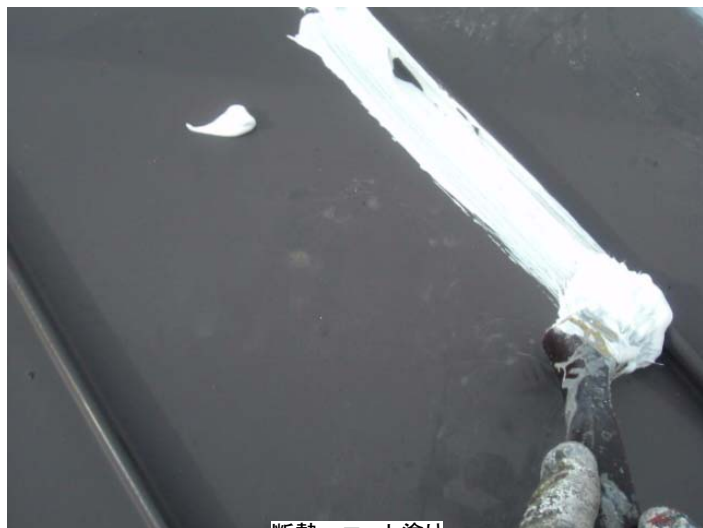
断熱αコート塗り
