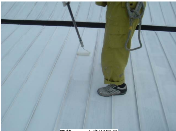
断熱αコート塗り2回目
