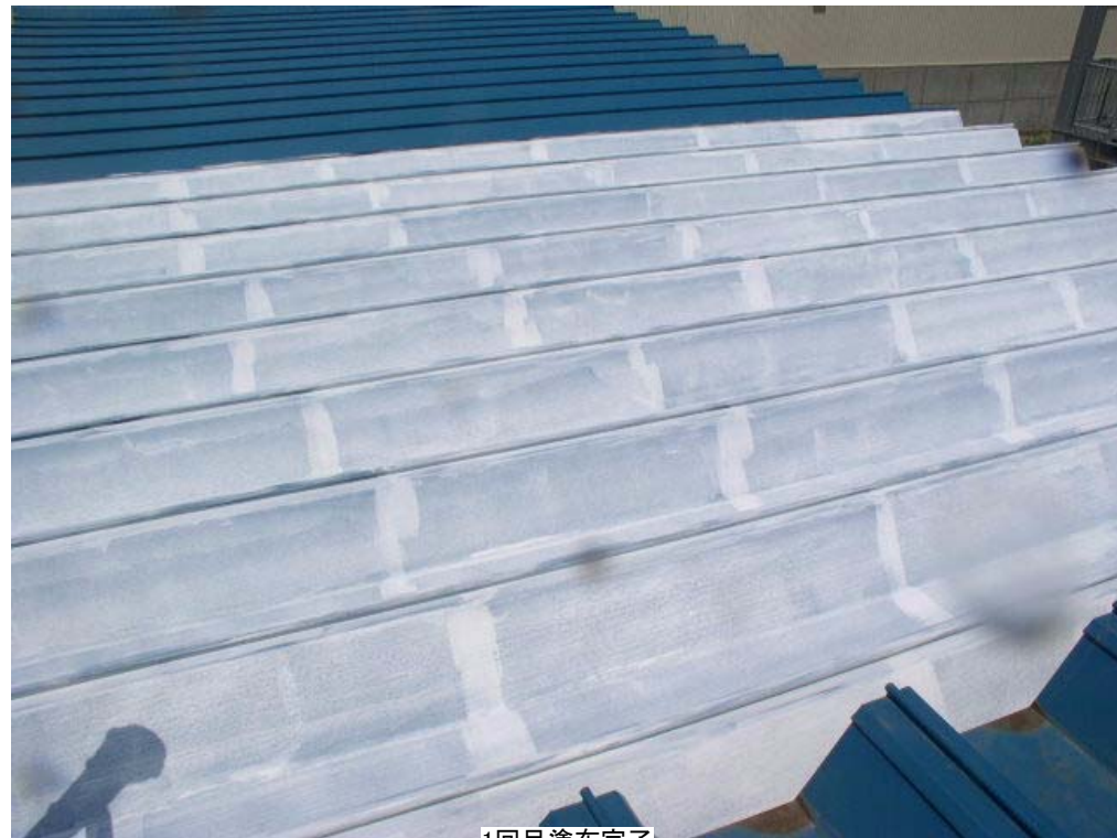
1回目塗布完了
