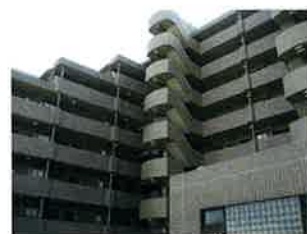
タイル外壁施工後
