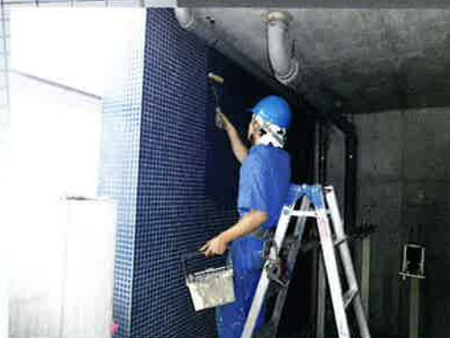
タイル面へのローラーによる施工
