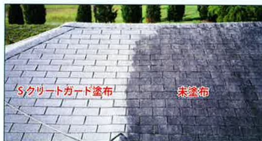
セメントタイルへの施工
