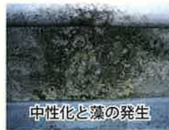
塩化カルシウムと凍害による複合的劣化
