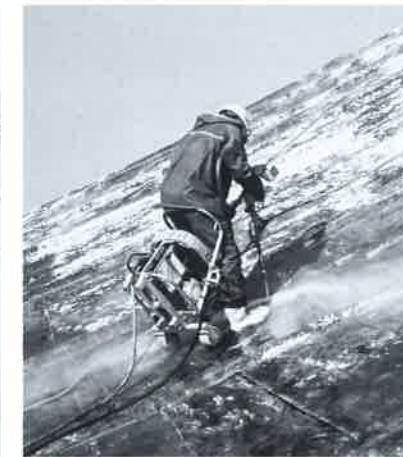
写真31 斜面上的剥離作業風景。
