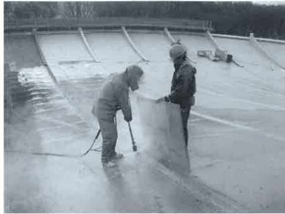
写真25 剥離作業の様様。
