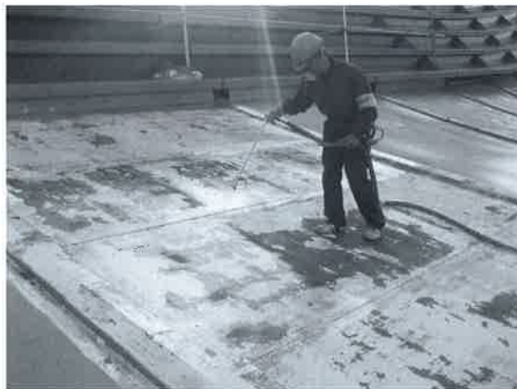
写真26 2回目の剥離剤(軟化剤)塗布。
