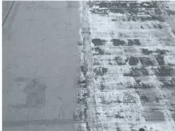
写真24 右半分が1回目の剥離を終えた部分。
