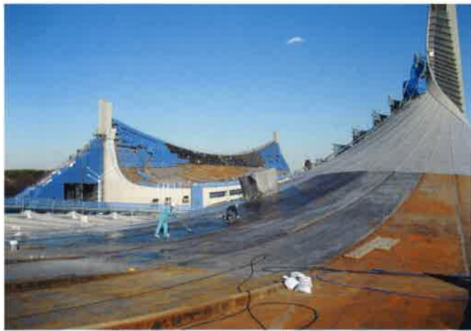
写真3 第二体育館の頭頂部付近での作業風景。
