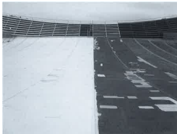
写真27 剥離作業後、劣化が顕著な部分に予め施された下塗り塗料。
