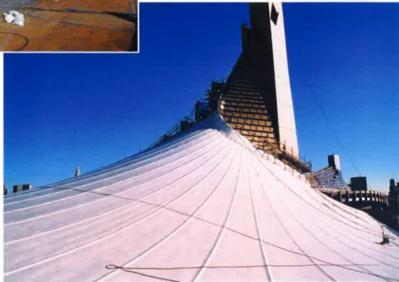
写真4 剥離を終え、下塗り塗装を終えたところ。
