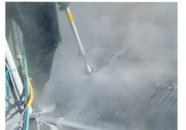
写真23 高圧での剥離作業。
