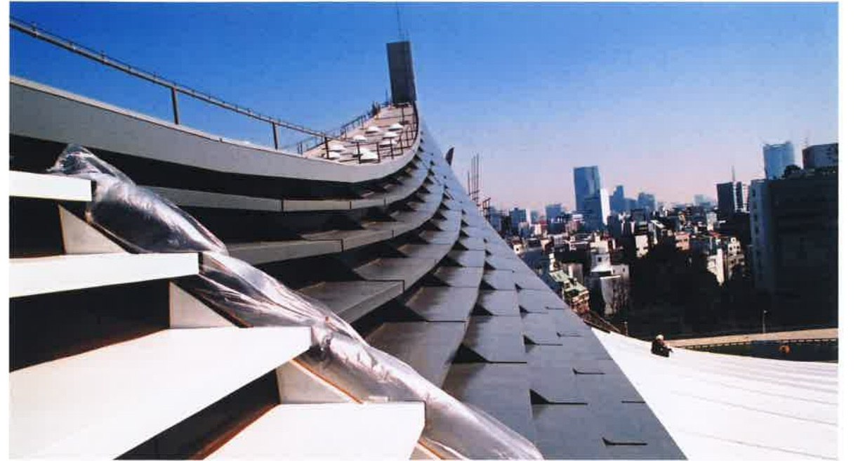
写真19 第一体育館東頭頂部の仕上がり(奥の部分)。
