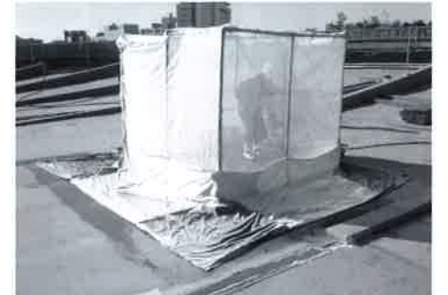
写真29 移動式の剥離小屋。塩ビパイプで外枠を組みメッシュシートで覆った小屋。剥離物の飛散防止に大活躍だった。
