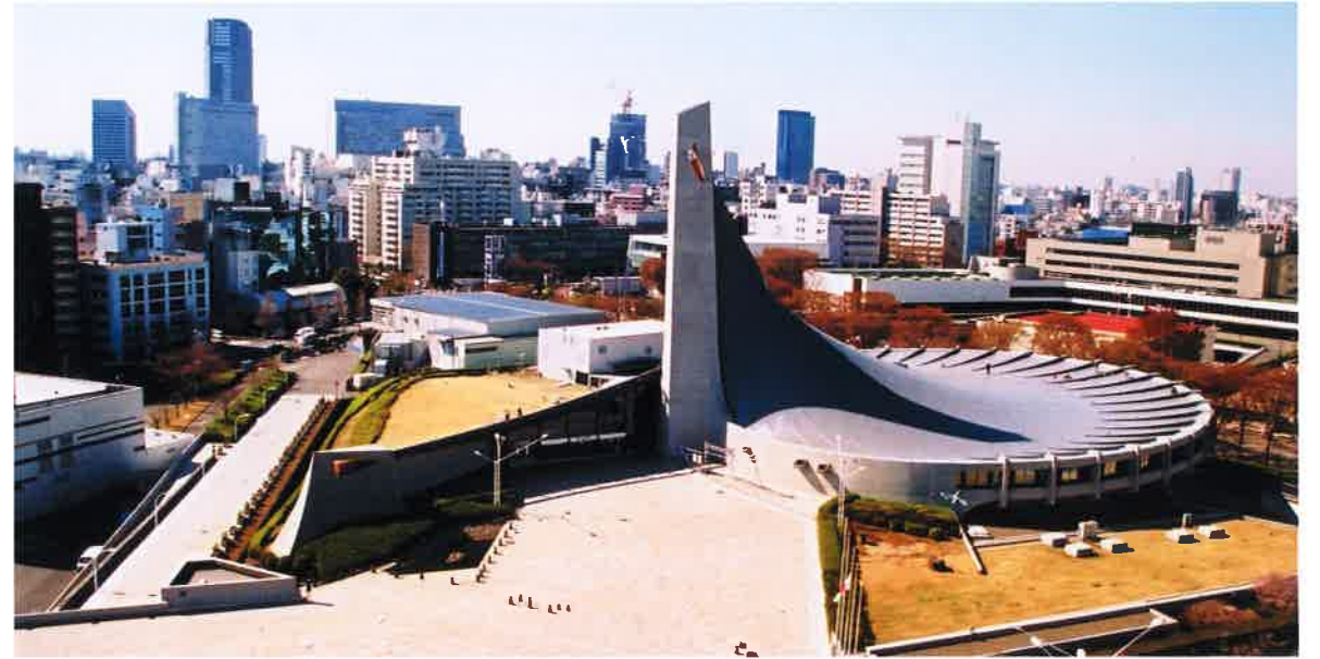
写真5 仕上がった第二体育館の屋根部(第一体育館から南西部を見る)
