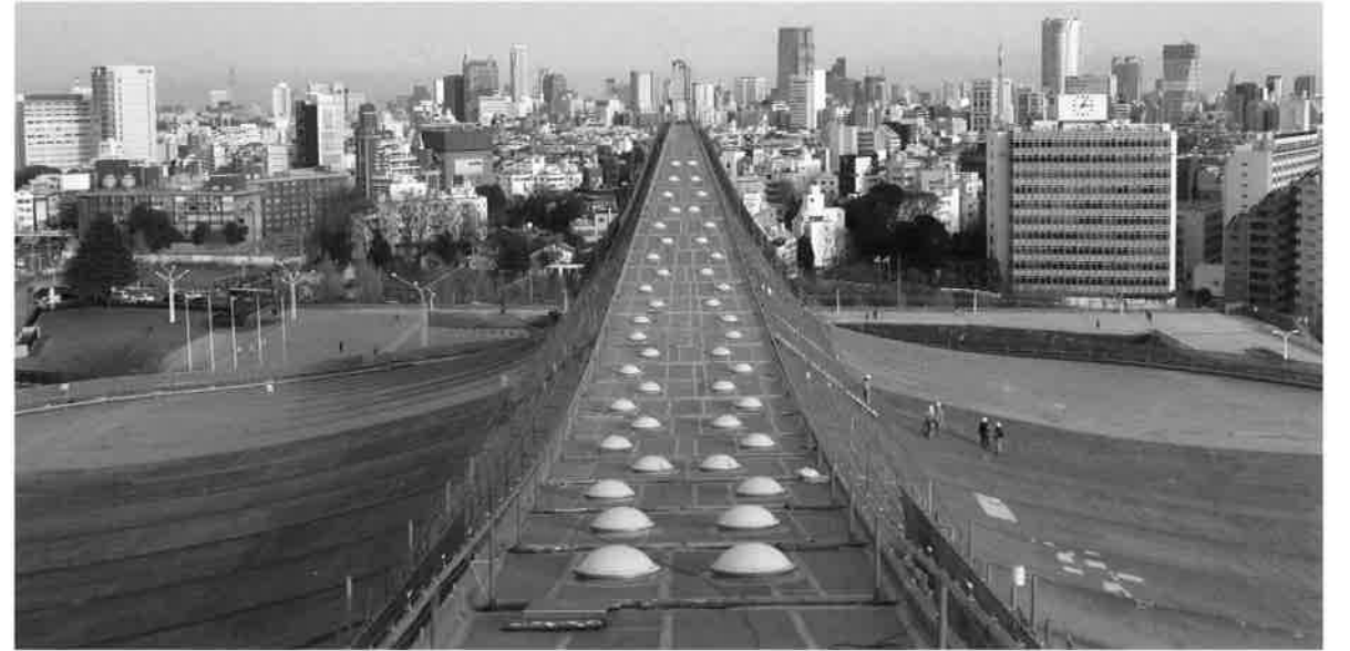
写真12 第一体育館の頭頂部付近から東側(渋谷)方向の眺め。半円形の帽子状のものは採光器。
