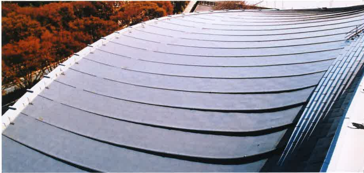
写真16 仕上を施したもの。丹下都市設計が推奨した太陽熱高反射塗料「ATTSU-9 (4F)」(あつないん) および無機系超低汚染コーティング剤「ニッペクリスタコート」が使用された。
