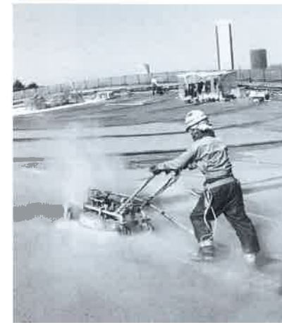
写真30 剥離機械での作業風景。
