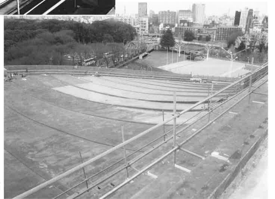
写真14 北東側屋根部の剥離作業。手前部分は第1回目の剥離が済んだもの。
