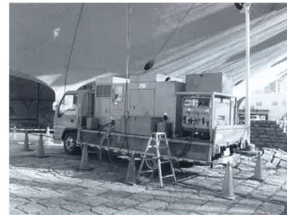
写真32 剥離作業の心臓部ともいえる超高压洗滌車。
